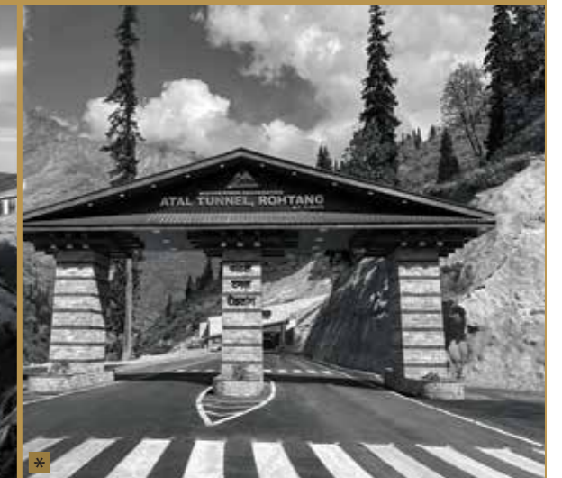
ATAL TUNNEL, ROHTANG
